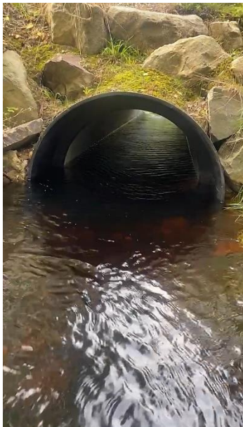
Bilde 4: Viser røret i bekken under bilveien i bekken fra Emmerudtjern. Røret ligger dypt i vegkroppen og er ikke problematisk for vandreende fisk av ørret.
