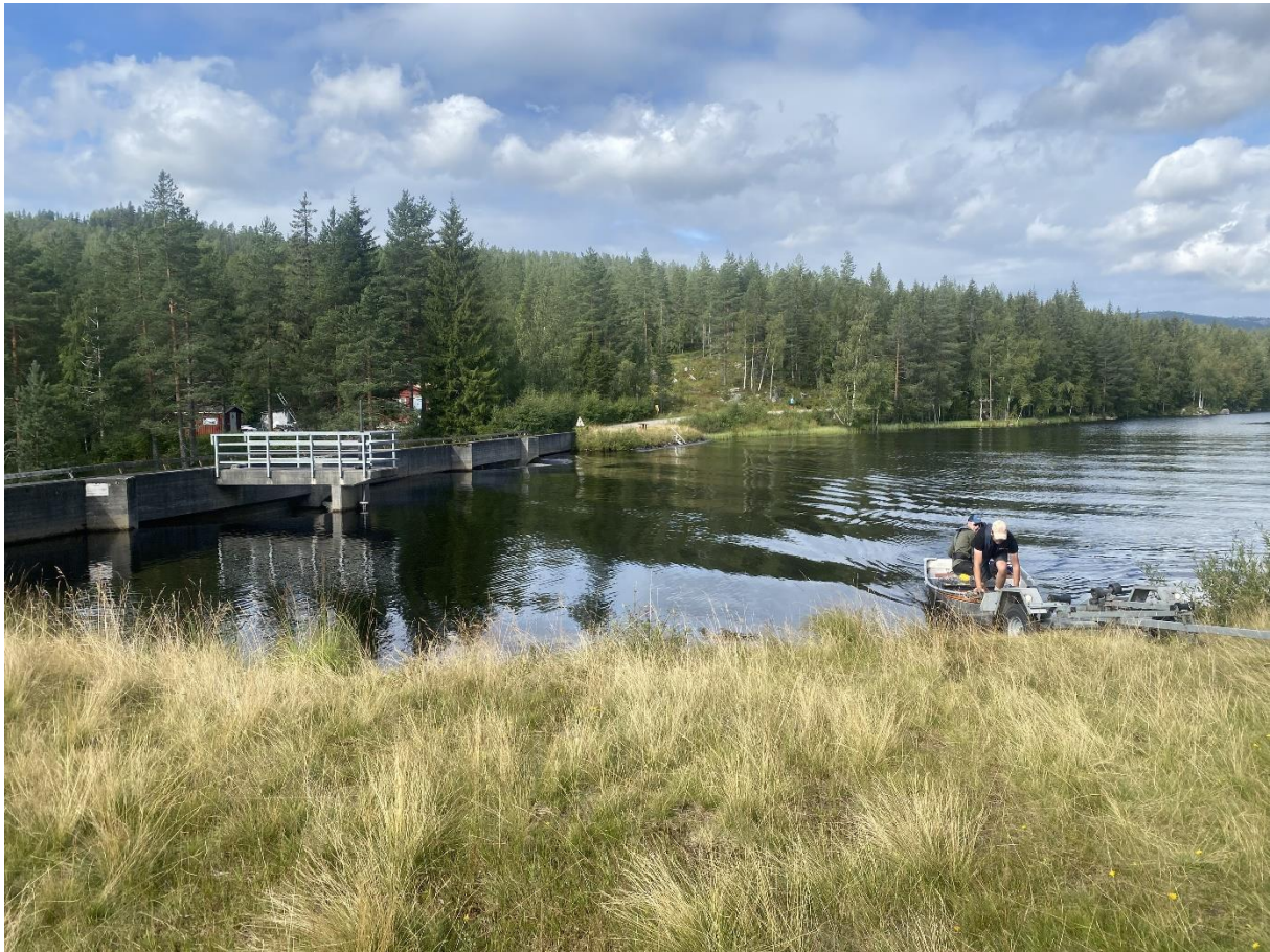
Bilde 1: Grytevatn sett fra parkering i sør mot dammen.
