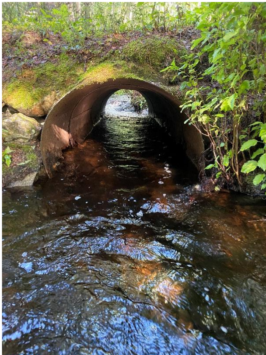
Bilde 4a: Bekken passerer ca. 30 meter oppstrøms utoaset under skogsbilveien i et rør som ikke har oppgangshindrende effekt.
